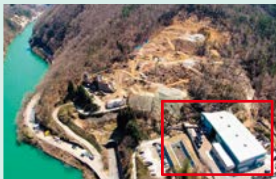
地滑り対策の進捗状況 (2022年4月8日撮影)
