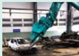
重機で自動車を解体
