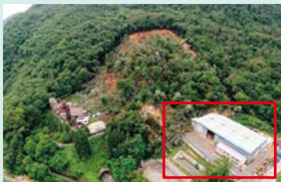
地滑り発生直後の状況 (2021年7月6日撮影)
