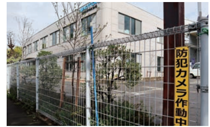
防犯カメラの設置により、社員の安心・安全を確保
